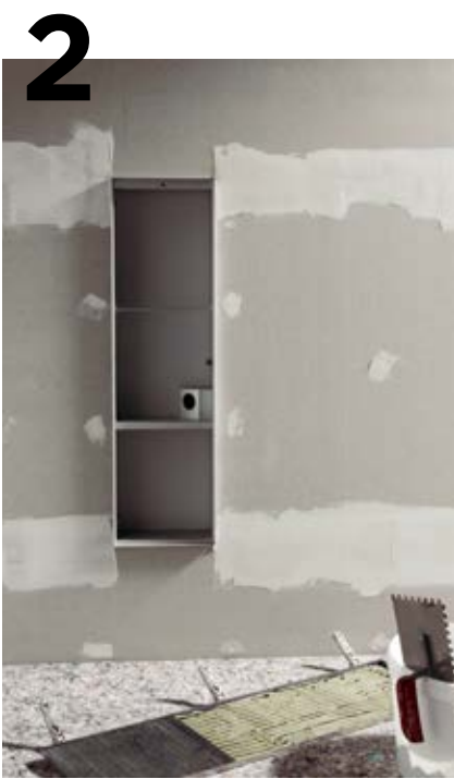
Die Tür wird temporär ausgebaut, damit sie einfacher verflies werden kann.
