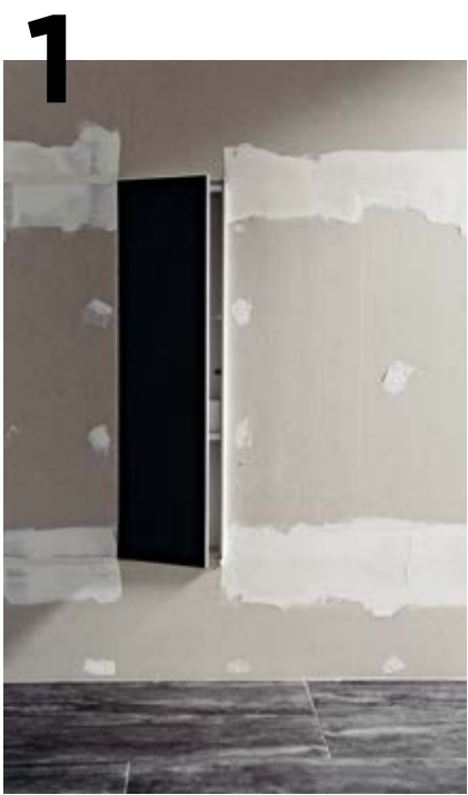
Das Modul wird passgenau in die Trockenbauwand eingesetzt.
