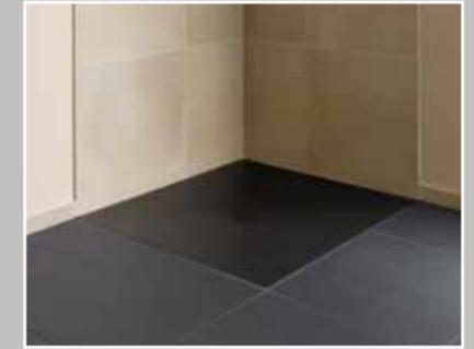
Zum Schluss wird die Duschfläche in den Rahmen eingesetzt und die Ablaufgarnitur vollständig angeschlossen. Die Fugen werden elastisch versiegelt. So bleibt die gesamte Konstruktion dauerhaft revisionsfähig.
