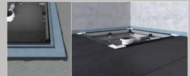
Die vorgeformten Dichtungsecken werden aufgesetzt und verklebt, das Dichtungsvlies wird am Rahmen aufgesteckt, umlaufend eine Rinne ausgebildet und dann mit Dichtschlämme zum Baukörper abgedichtet. Dann kann das Bad verfliesen werden und im letzten Schritt die Duschfläche oder Duschwanne eingesetzt werden.
